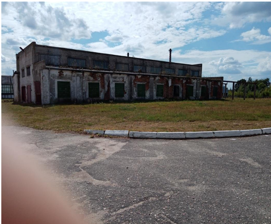
Цех ЖБИ с котельной, аг.Малая Берестовица
