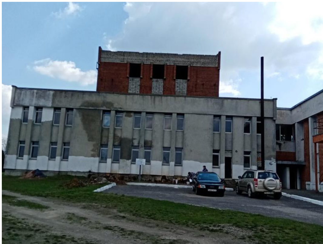
Незавершенное строительство клуба аг. Пограничный, степень готовности 50%. НАЧАЛО СТРОИТЕЛЬСТВА 1998 ГОД.
