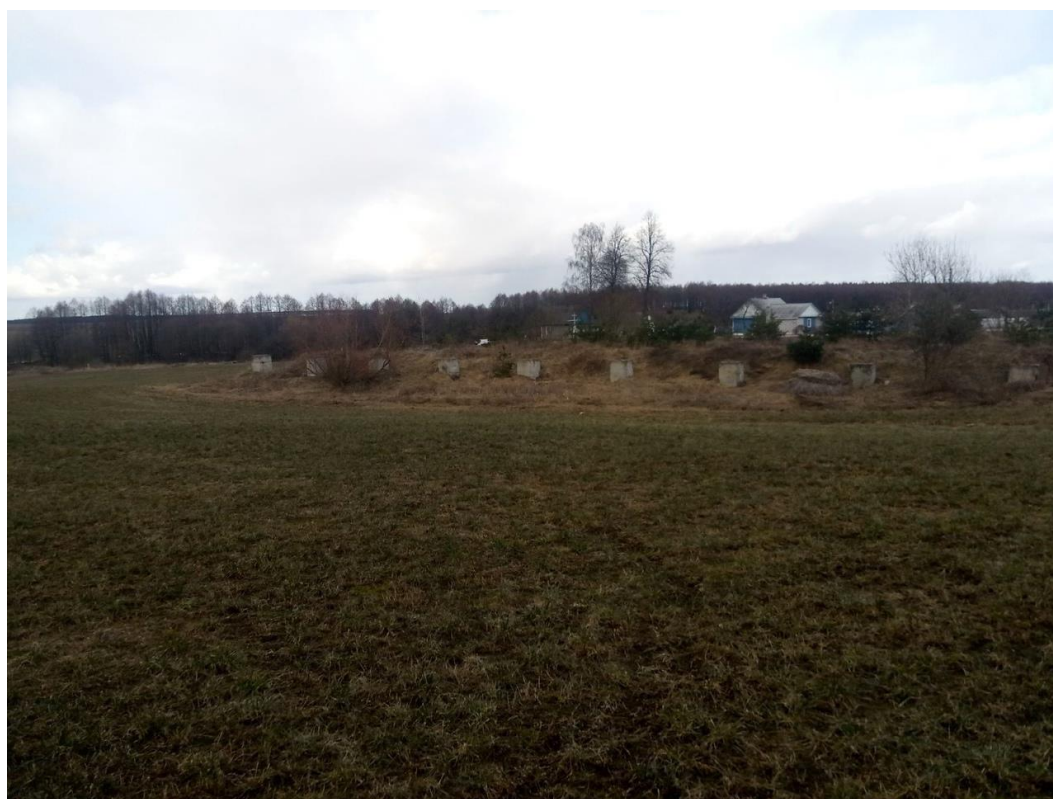
НЕЗАВЕРШЕННОЕ СТРОИТЕЛЬСТВО ЦЕХА ПО РОЗЛИВУ МИНЕРАЛЬНОЙ ВОДЫ
