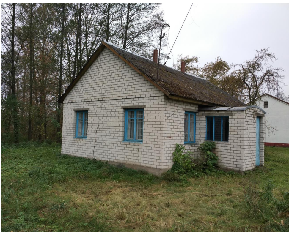
Комплексно-приемный пункт д.Поплавцы 2, принят на баланс в 2012 г., площадь 32,00 кв.м.
