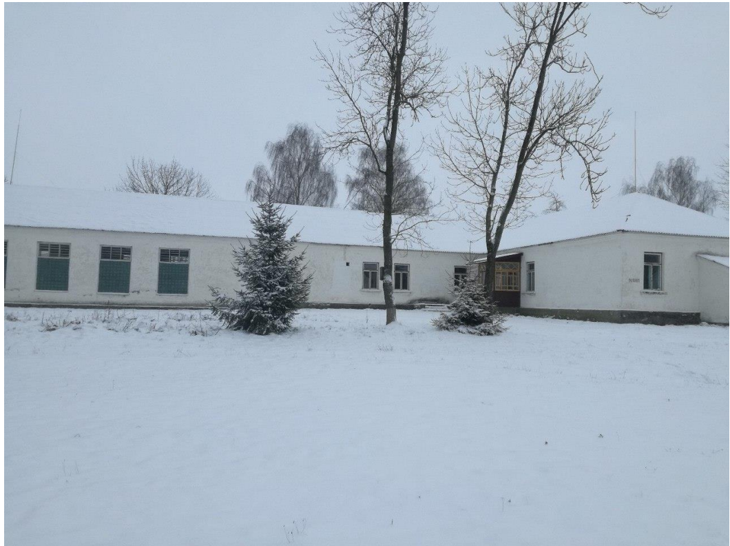
Здание базовой школы аг. Массоляны, ул.Шоссейная,1
