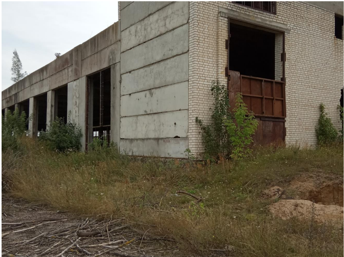
Незавершенное строительство кирпичного завода (часть) аг.М.Берестовица, площадь 3240,00 кв.м.
