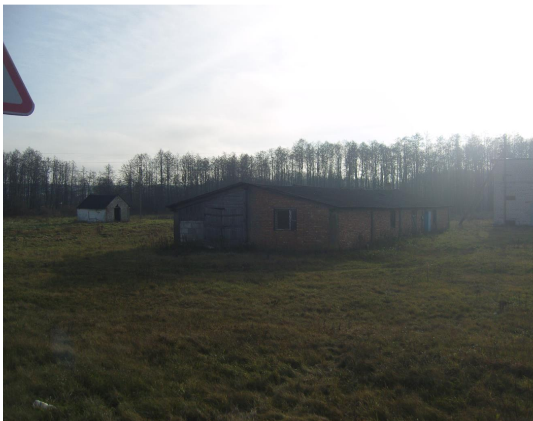
Пилорама д. Поплавцы, 1950 год постройки, площадь 83,00 кв.м.
