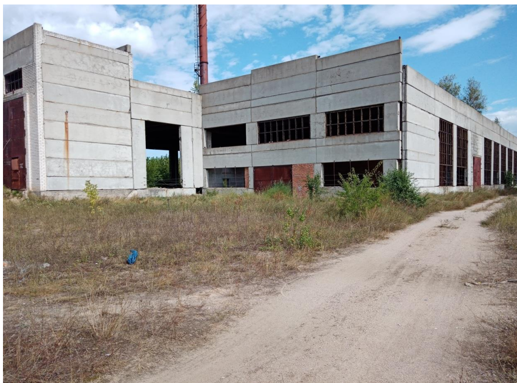
Незавершенное строительство кирпичного завода (часть), аг.Малая Берестовица
