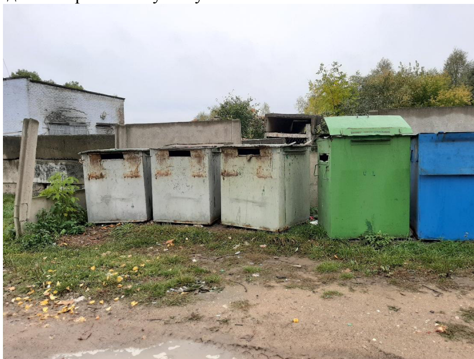
Рисунок 2.5 Пример отсутствия наземного водонепроницаемого покрытия на контейнерной площадке, расположенной в г. п.Большая Берестовица, ул.Ленина,7.
