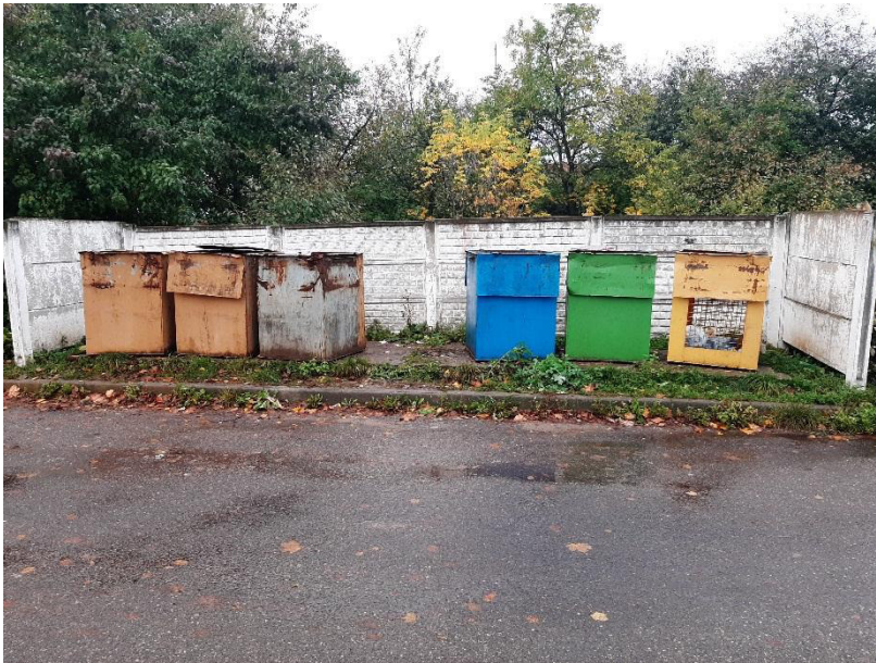
Рисунок 2.2 Отсутствие повреждений в ограждении на контейнерной площадке в г.п.Большая Берестовица,ул.Ленина,35А.
